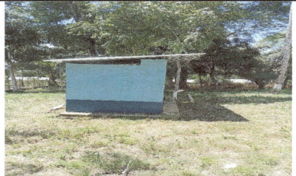
Foto 6: Servicios sanitario remozados.
