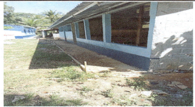
Foto 4: Aula y cocina remozadas
